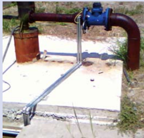
• 地下水监测 Groundwater monitoring
