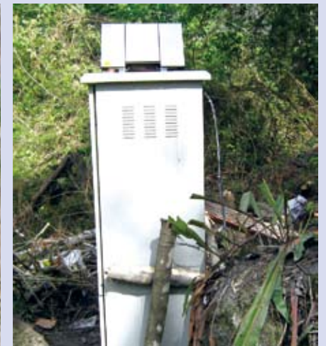
• 地下水监测 Groundwater monitoring
